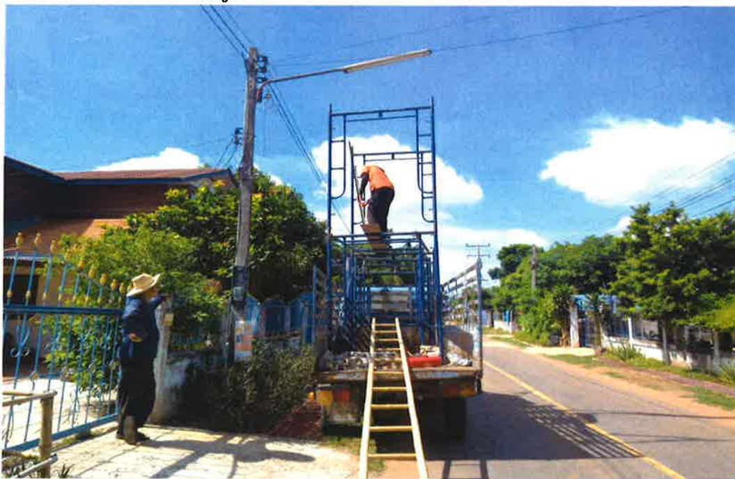
ภาพถ่ายขณะดำเนินการซ่อมไฟฟ้าสาธารณะ บ้านหนองโน หมู่ที่ 5 ตำบลโพหนอง อำเภอสีดา จังหวัดนครราชสีมา
